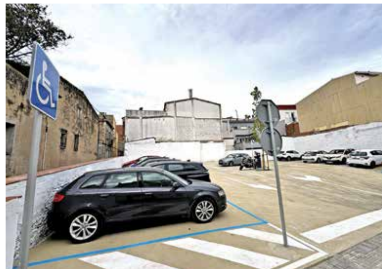
AL CARRER DE LA TORRE. L'aparcament és en ple nucli urbà
