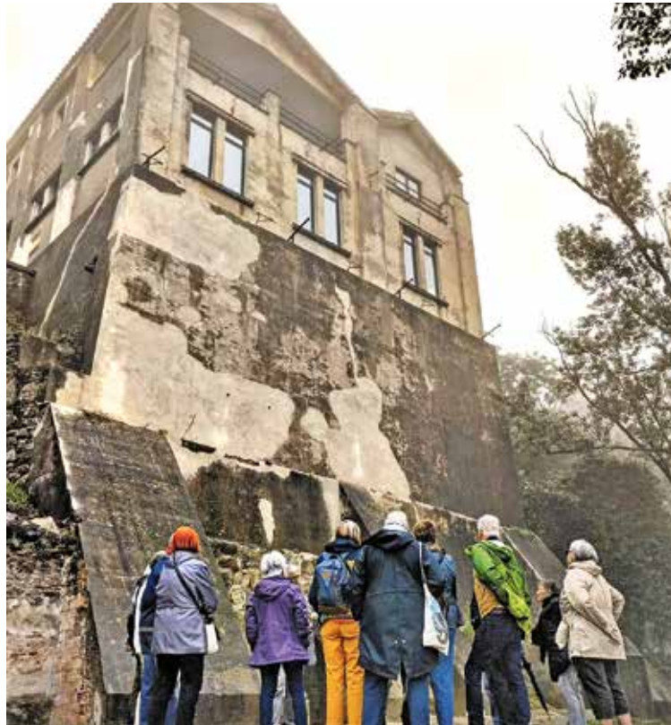
DESCOBERTA. Un grup visitant la mina Canta el passat mes de juny
