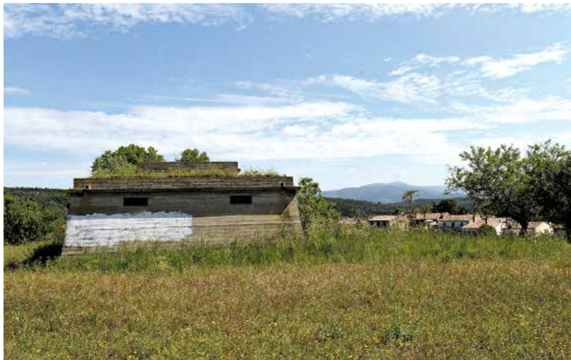
DIPÒSITS MUNICIPALS. És on es col·locarà el nou mòdul de tractament, que hauria d'arribar a finals d'aquest mes
