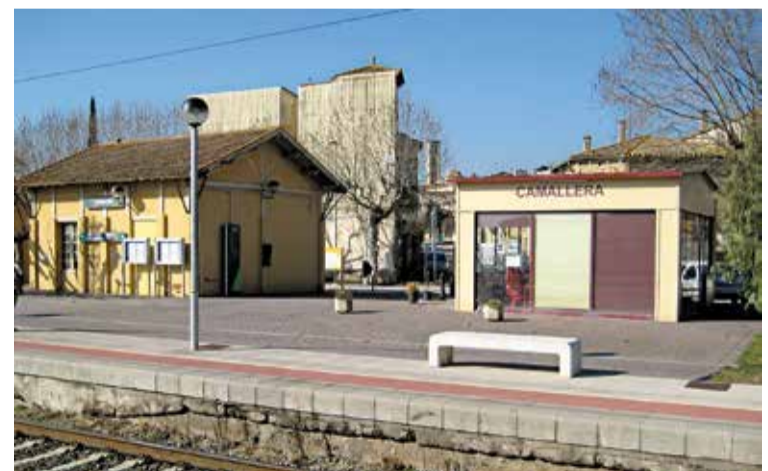
ESTAT ACTUAL DE L'ESTACIÓ. S'hi crearà un recorregut lliure d'obstacles ADIF
