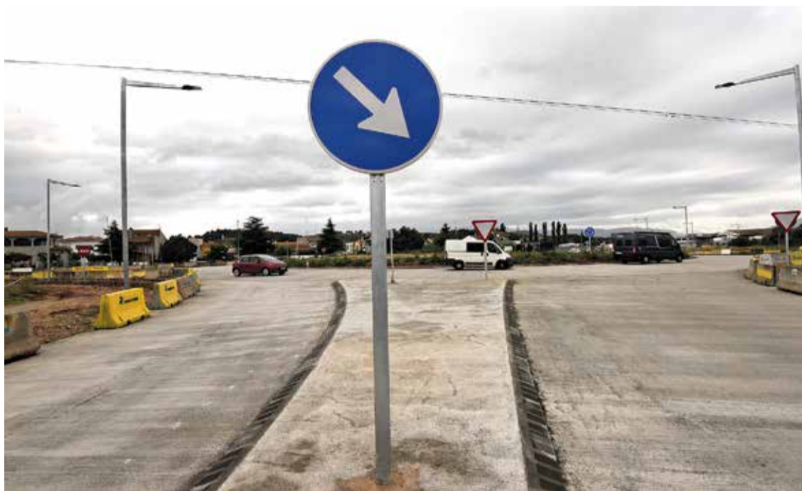
CONSTRUCCIÓ PIONERA. Una de les primeres rotondes de l'Estat fetes amb formigó per més durabilitat
