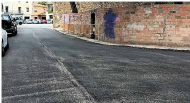
NOU PAVIMENT. L'actuació es va dur a terme durant el mes d'abril
