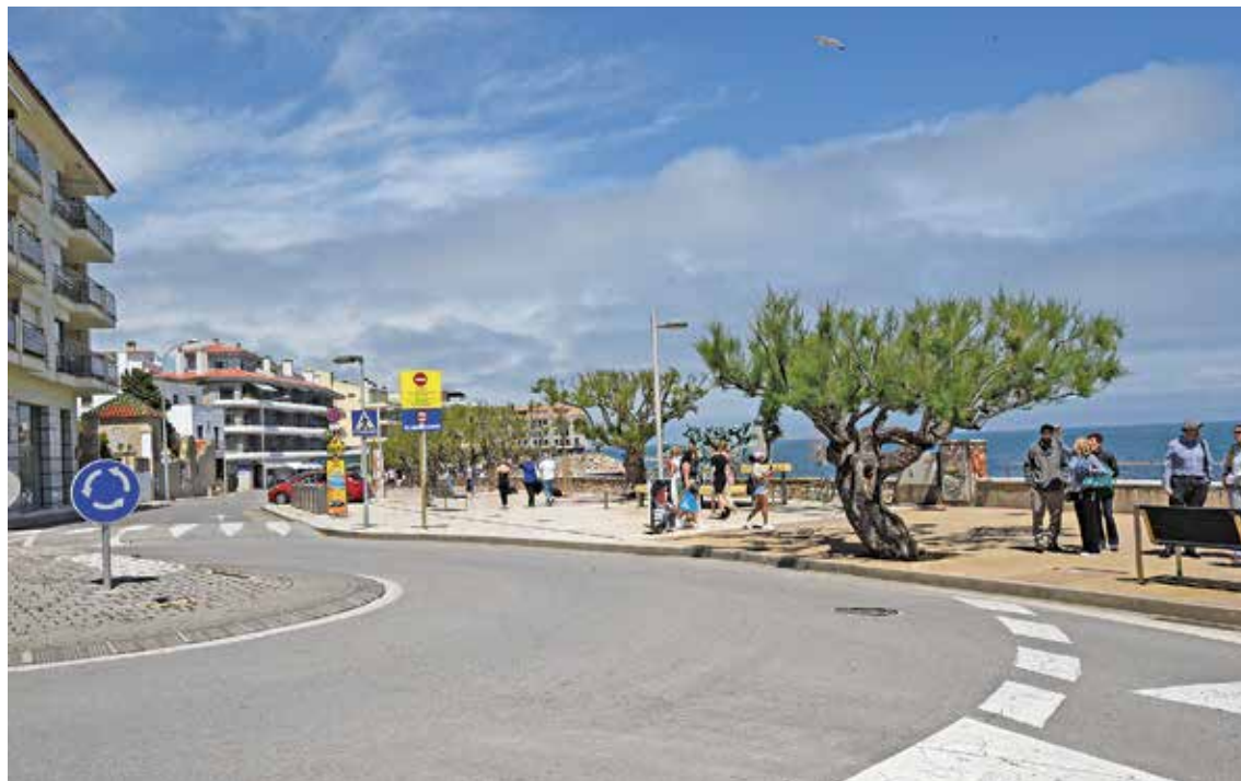
ÚLTIMA FASE. La reforma del passeig completa les dues fases anteriors i permetrà construir una imatge unitària
