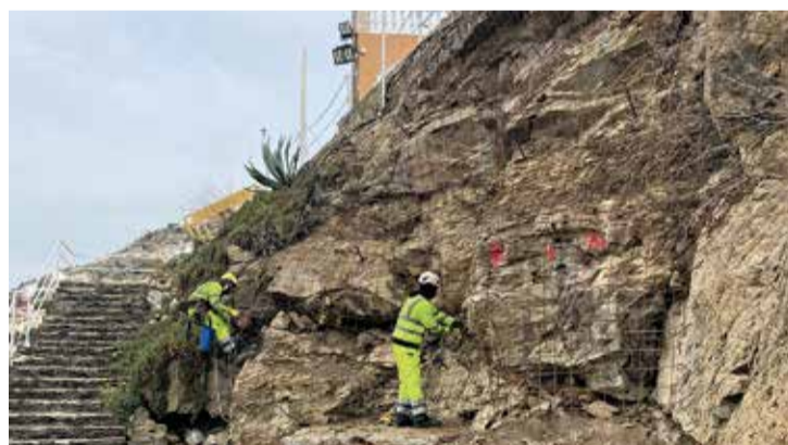
TASQUES D'ARRANJAMENT. Després d'un despreniment de terres
