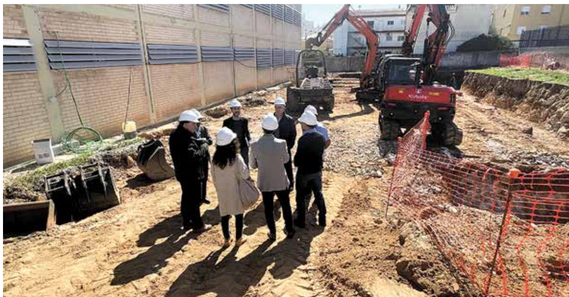
DIJOUS PASSAT. Presentació de l'inici d'obres en un solar adjacent al CAP actual que ha estat cedit per l'Ajuntament A.J. DE L'ESCALA
