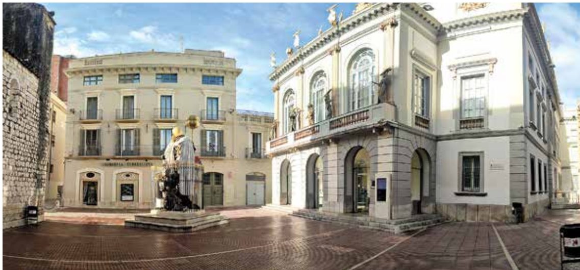
L'EDIFICI. Construït l'any 1981, pertany a la família Bech de Careda i està declarat bé cultural d'interès local
