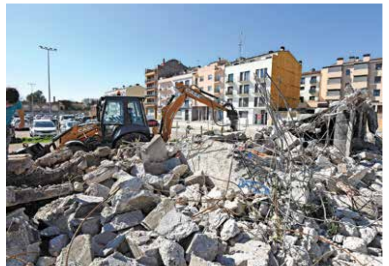
AQUEST DILLUNS. Aspecte del solar sotmès a treballs d'ampliació i millora
