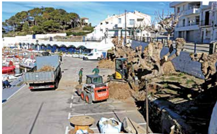
PRIMERS TREBALLS. A l'espai on es construirà el nou edifici
