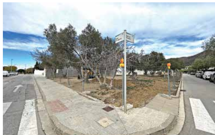
INICI DE LES OBRES. Els treballs a la zona de l'olivar
